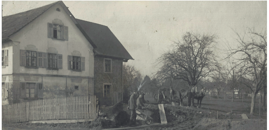
Das Haus der Familie Hagen in der Wallstraße 19
