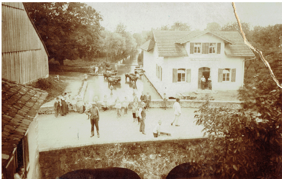
Dorfbachbrücke mit Sennerei und Viehtränke, ca. 1910
