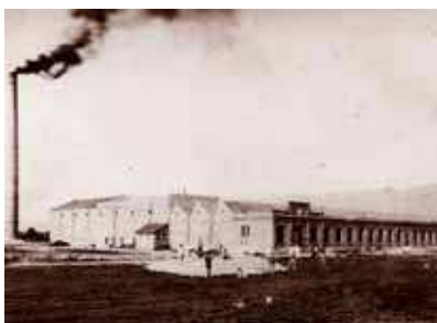
E. Offermann, Kammgarnspinnerei teilweise noch im Bau, 1896
