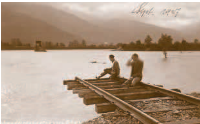
Rheindurchbruch in Schaan, Eisenbahnbrücke stark beschädigt
