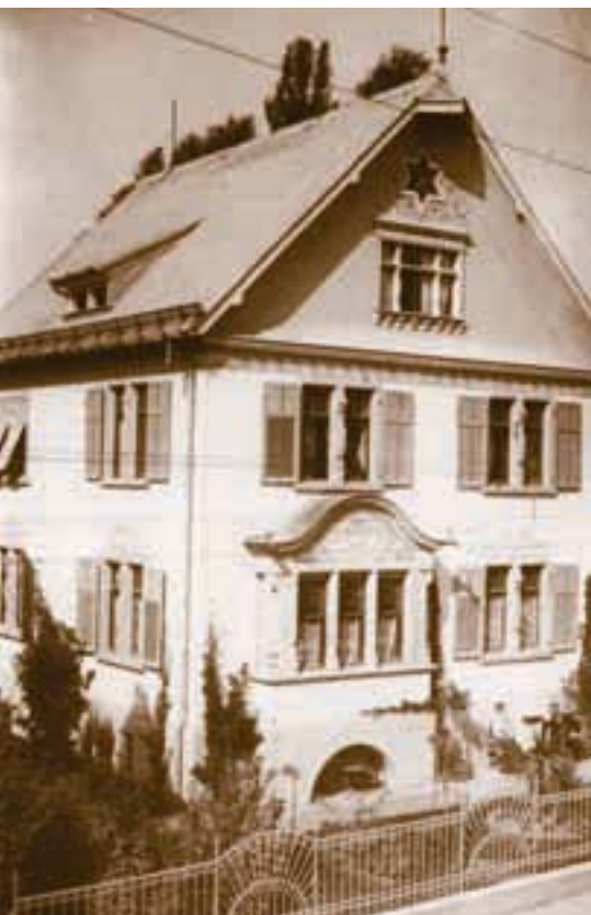
Villa-Jussel nach der Fertigstellung
