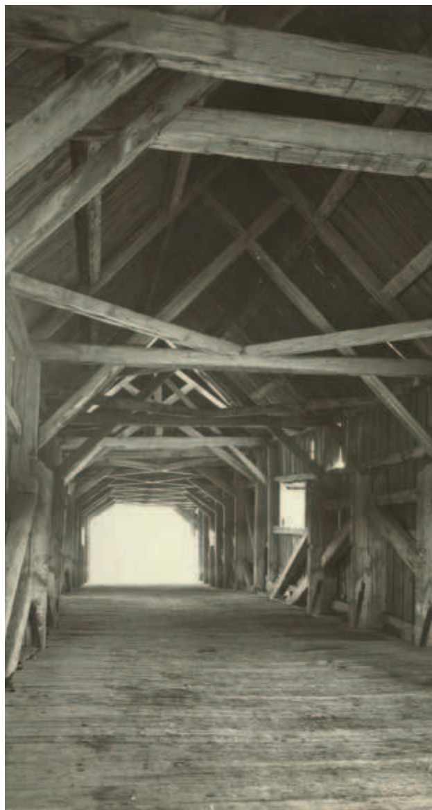
Innenansicht – Holzkonstruktion, abgebrochen 1917
