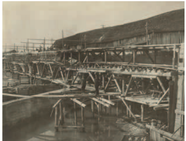
Bregenzerachbrücke Neubau 1916, Blick nach Lauterach
